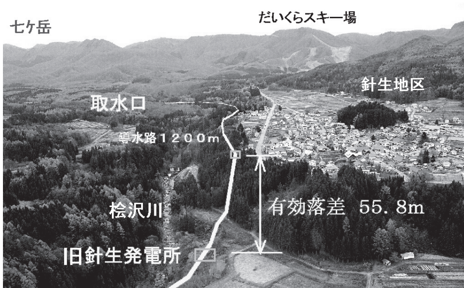
旧針生発電所の状況
