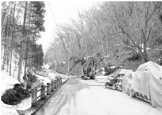
現在も復旧工事中の旧国道289号線（平成29年4月撮影）
