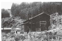
旧針生発電所
